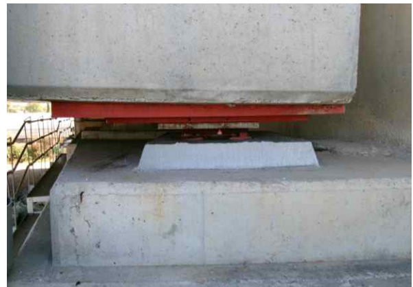
교량 받침 가동량 측정
