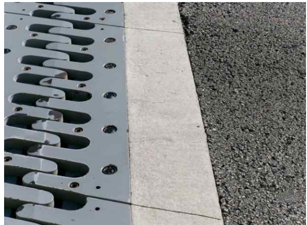
A1 후타재 균열( C_w=0.3\text{mm} 미만)
