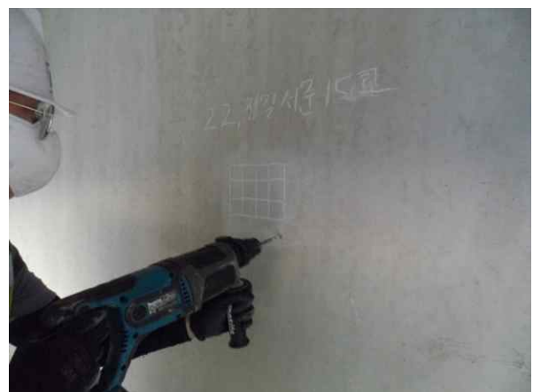
탄산화깊이 측정 현황
